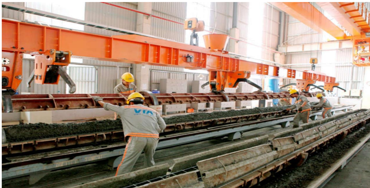
Hệ thống rải bê tông
