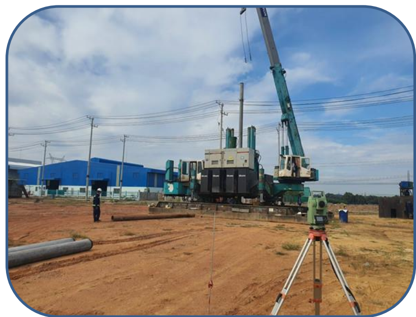
Cung cấp và thi công ép cọc D300 tại KCN Đức Hòa 3
